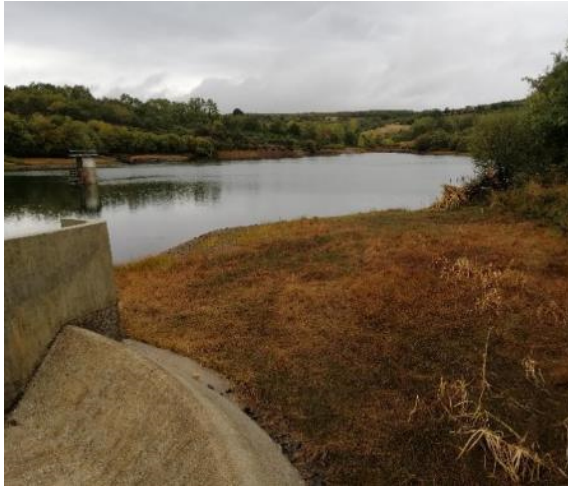
Barragem da Prada em Vinhais, zona de observação da Terra Fria.
